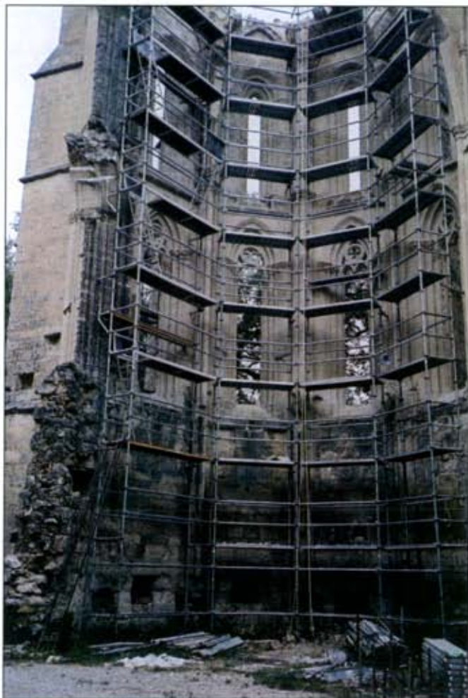
Consolidación del ábside. Foto: Balbanuz Benavides
