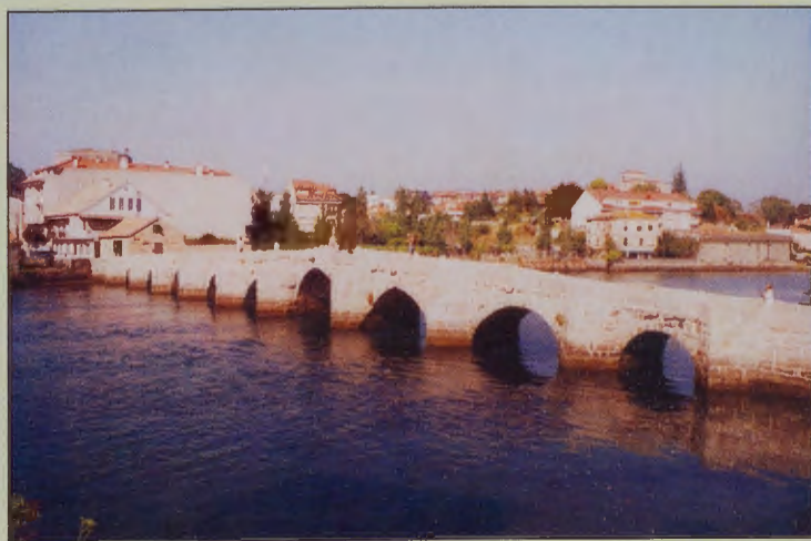
PUENTE DE LA RAMALLOSA.
