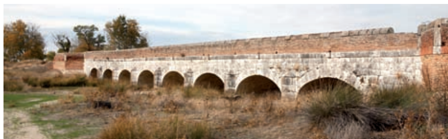
Puente sobre el río Zapardiel, en las proximidades de San Vicente del Palacio.
