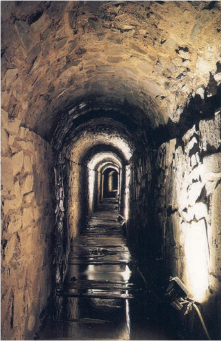
Fig. 4: ASTORGA: Tramo de cloaca romana.
