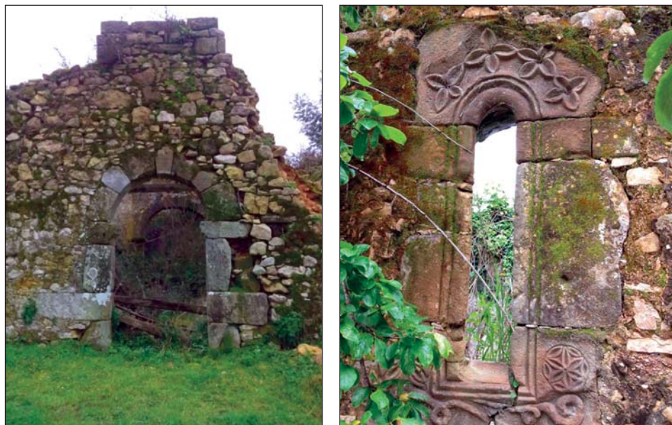
Figura 15. Capilla de San Pedro de Villamartín Alto (Nava) y detalle de la ornamentación en uno de sus vanos (E. Carrocera y L. Blanco).
