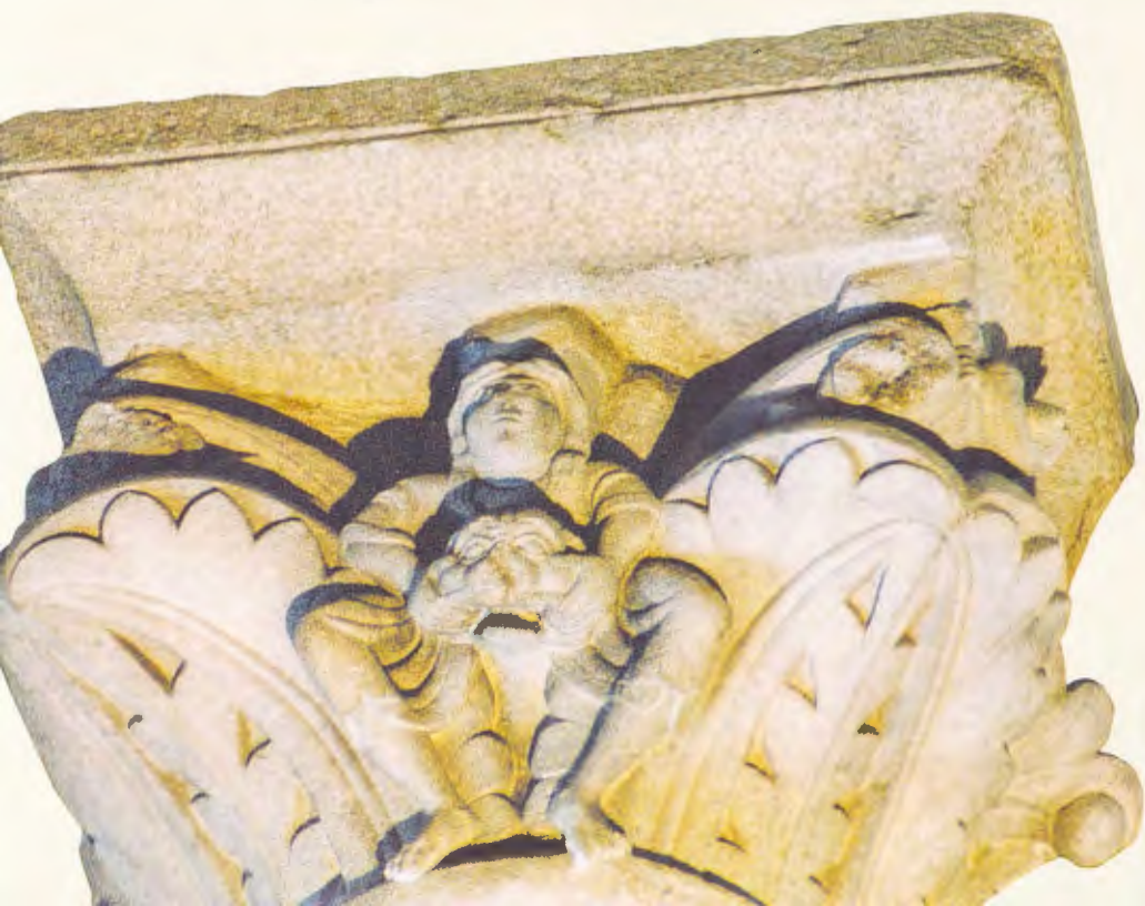
Figura 2: Capitel del transepto norte, junto al acceso de las Platerías.
