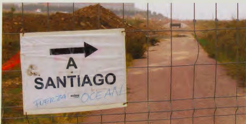
Desvío provisional del Camino por las obras del polígono de Monte Cantabria.
