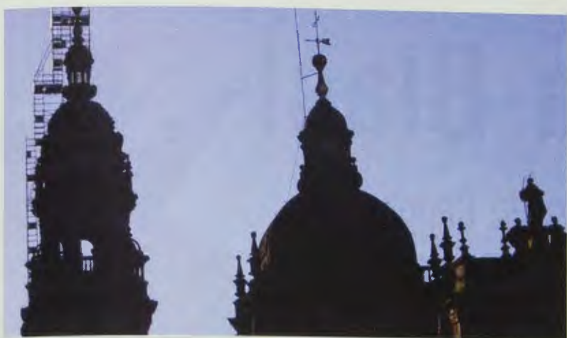
Imagen de la torre La Berenguela en obras
