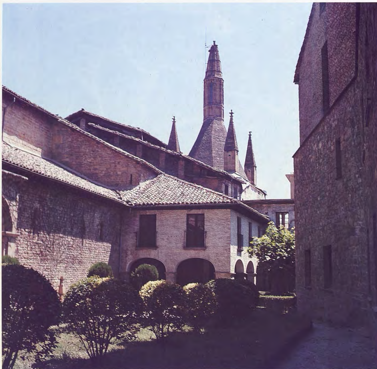
Chimeneas de la cocina de peregrinos de la catedral de Pamplona.
