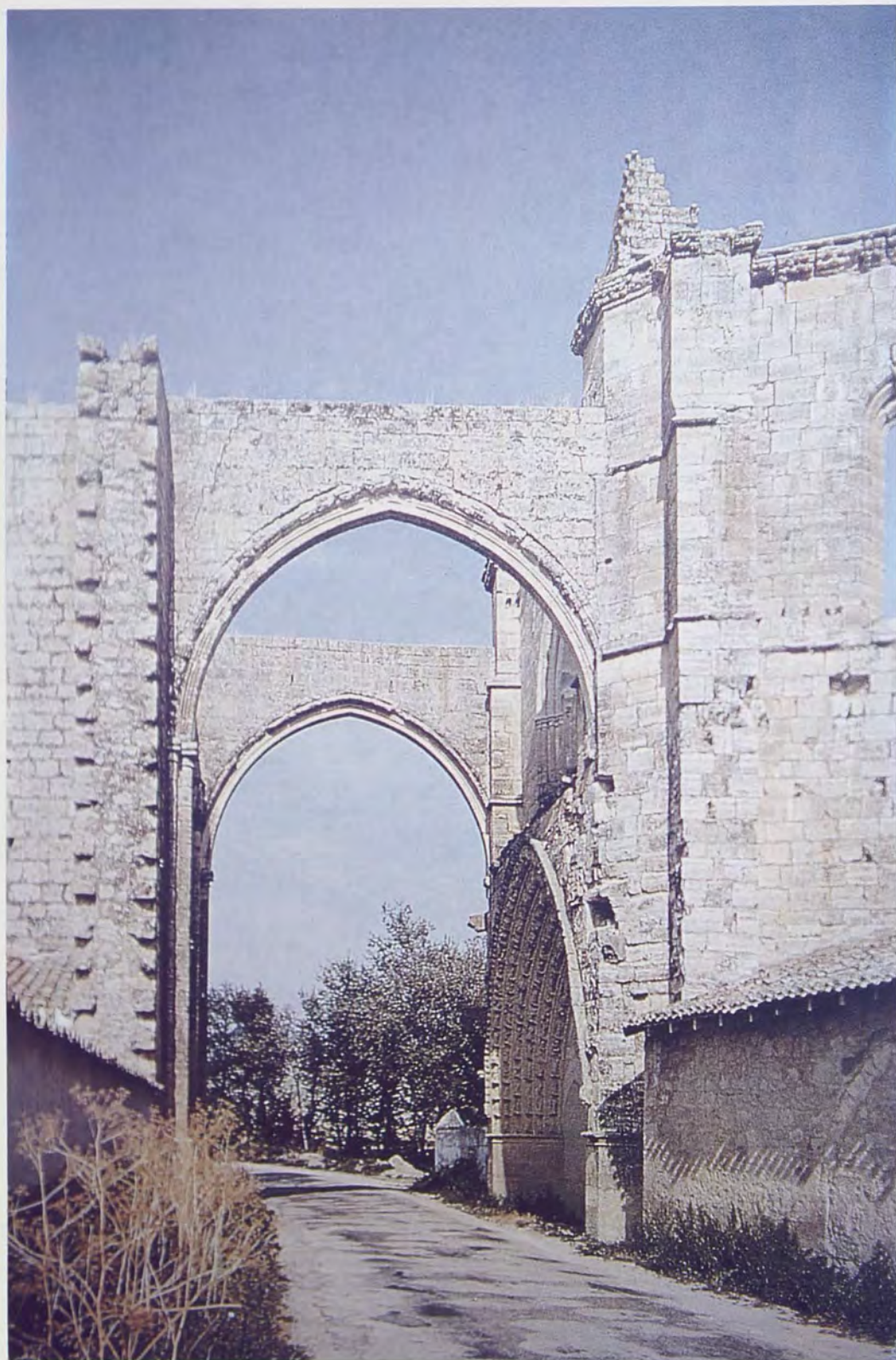
Ruinas de la gran encomienda de San Antón. Castrojeriz.
