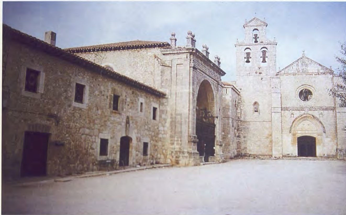
Iglesia y hospital de San Juan de Ortega.
