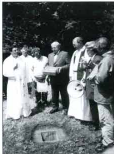
Colocación y Bendición de la 1ª Piedra. Albergue de La Faba. Fotografía: Liliana Simon
