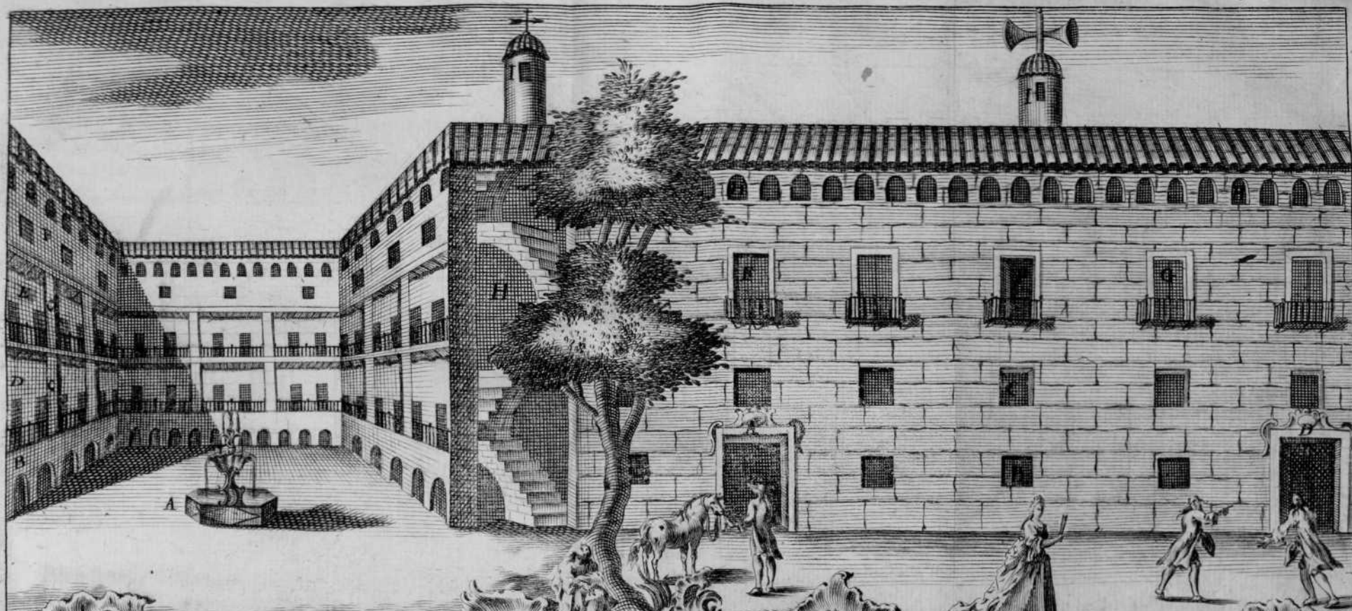
Vista interior de un quadro de Parada
