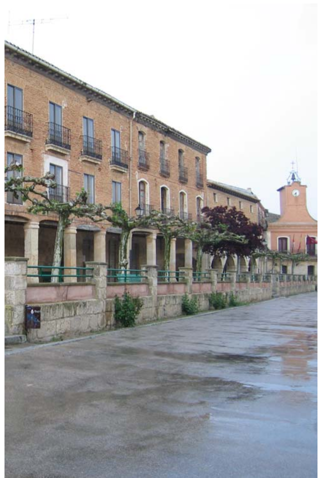
Plaza Mayor de Castrojeriz, Burgos.
