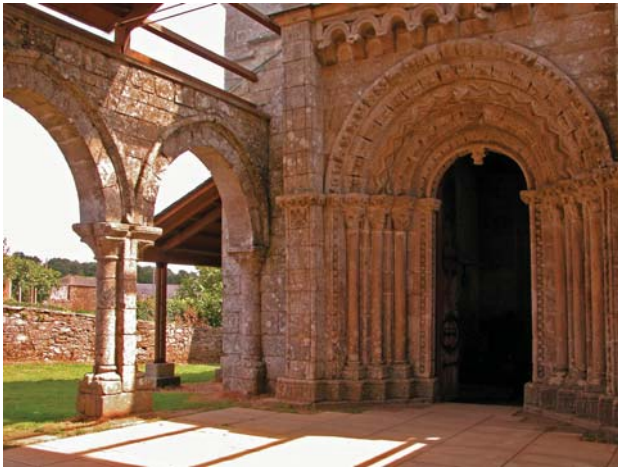
Portada principal de la Iglesia de Santa María de Villar de Donas, Palas de Rei.
