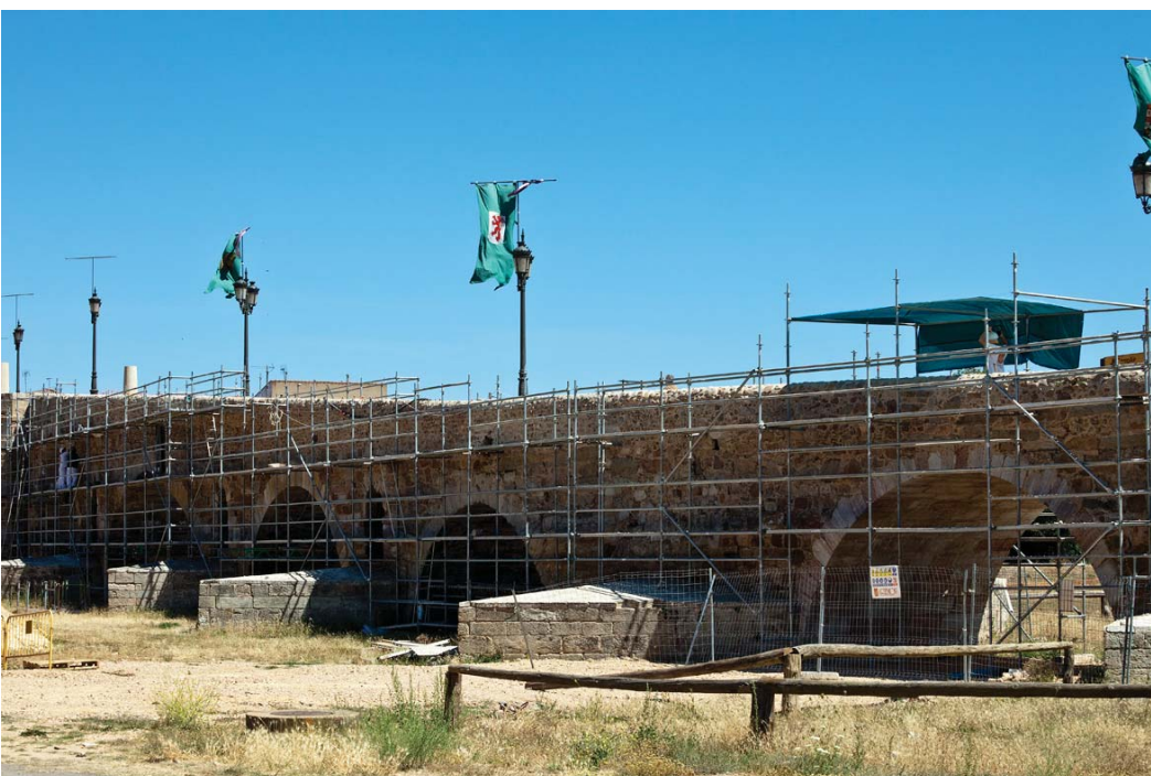
Restauración y Consolidación del Puente. Hospital de Órbigo.
