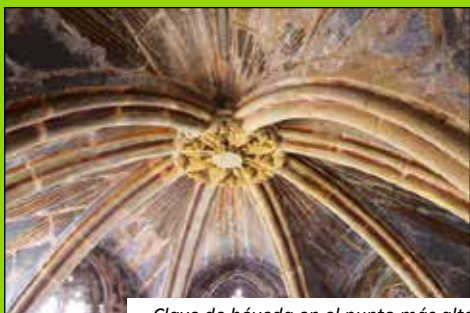
Clave de bóveda en el punto más alto de la tracería del cimborrio. Otra recuperación.
