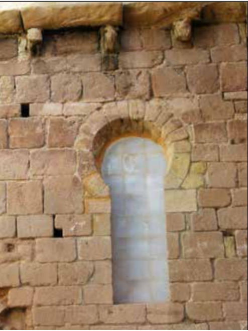
Santa María La Real (Nájera, La Rioja), empleo de areniscas de grano fino (Facies Nájera) empleadas en su construcción.
