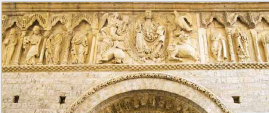
Iglesia de Santiago (s. XII), Carrión de los Condes (Palencia), uso de calizas miocenas y dolomías cretácicas y canteras de Villaescusa de Ecla.
