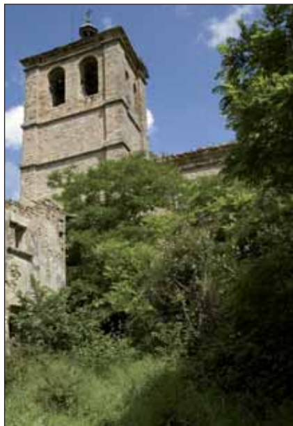
La maleza se apodera de la iglesia de San Miguel en el abandonado pueblo de Tiernas (Zaragoza). Jorge Martínez-Cava
