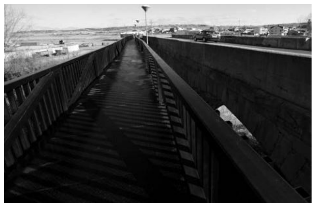
Pasarela sobre el río Tuerto
