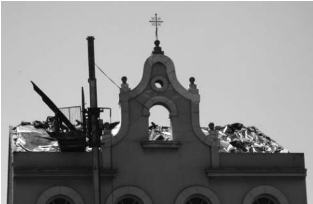
Arreglo del tejado
