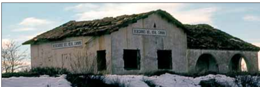
Estado actual del apeadero de Bercianos del Real Camino (León). Jorge Martínez Cava.
