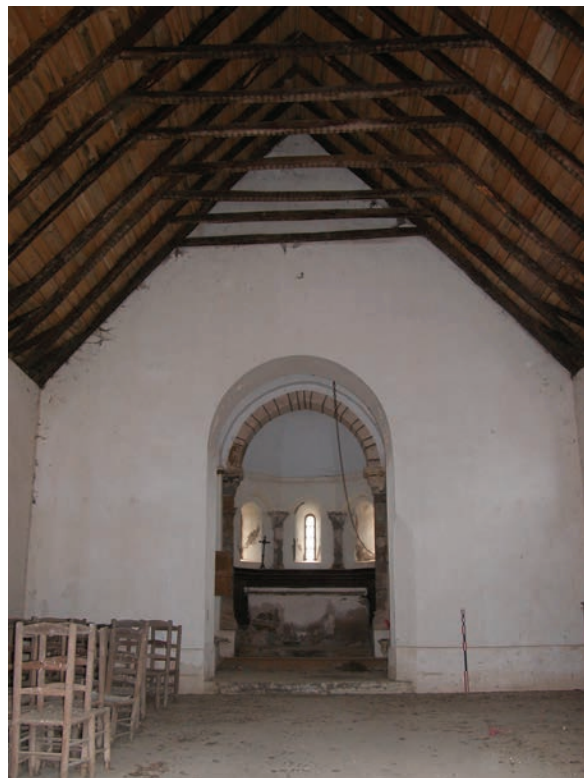
Fig. 13 Arc en plein cintre lancé entre la nef et la travée de chœur de la chapelle Saint-Maurice d'Auzits (Y. Mattalia).
