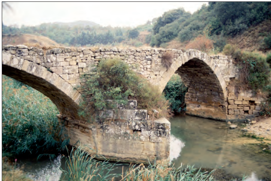
Puente sobre el río Salado, Lorca (Navarra). José Ignacio Díaz
