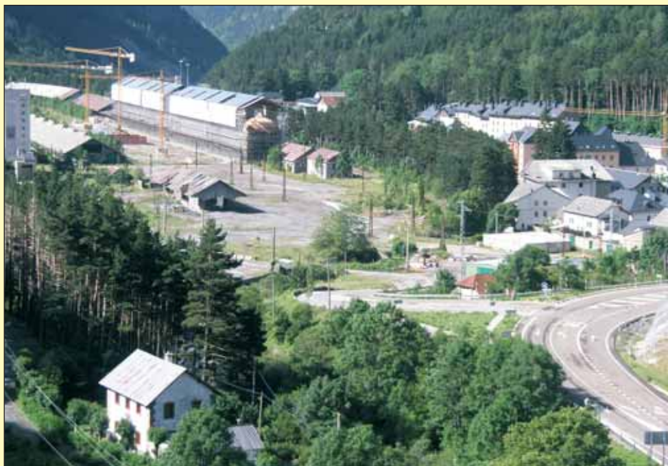
Vista actual de Canfranc Estación, con el edificio de la Estación en obras. Alfredo Núñez
