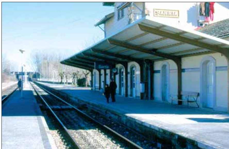
Vista actual de la Estación de Sarria. J.M. Cava
