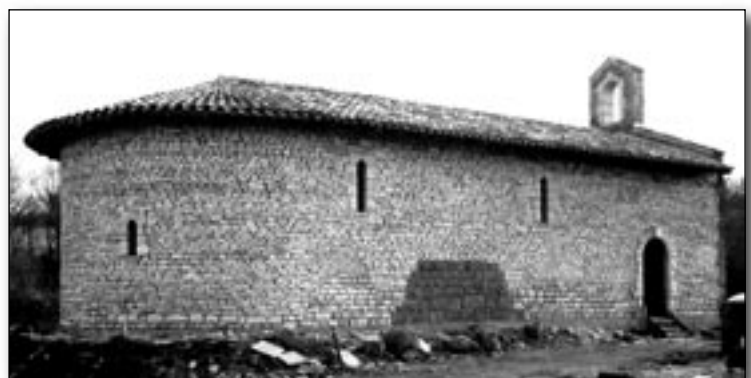
Après reconstruction noter en sombre l'ancien mur
