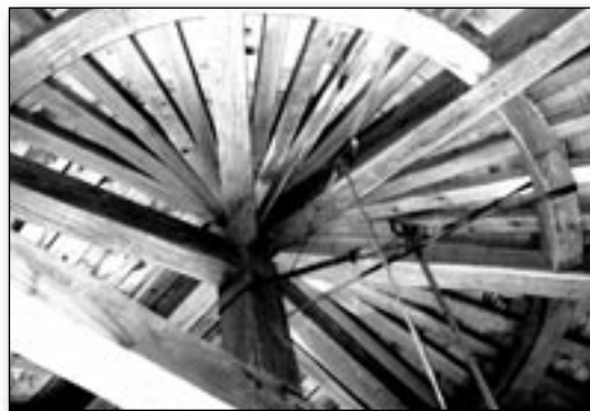
Détail de la charpente rénovée
