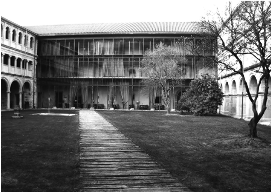
Fig. 1. Vista del ala norte del claustro grande: 'inexistente' en 1909 (AMB Meakin) y reconstruida mediante la solución de un muro cortina, 2014. (Archivo fotográfico de la autora)
