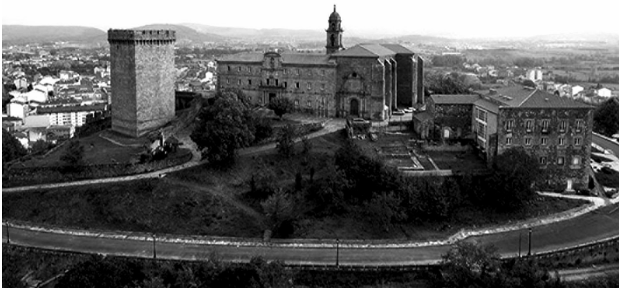
Fig. 4. Vista aérea del conjunto monumental antes (ca. 1952, Archivo fotográfico de la Real Academia Gallega de Bellas Artes) y después de su conversión en parador (ca. 2010, Archivo fotográfico del ayuntamiento de Monforte de Lemos).
