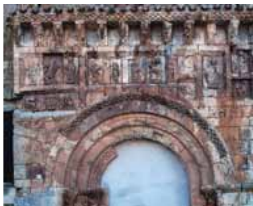
Fig. 21. San Quirce de Burgos, puerta norte, 1125-1150.
