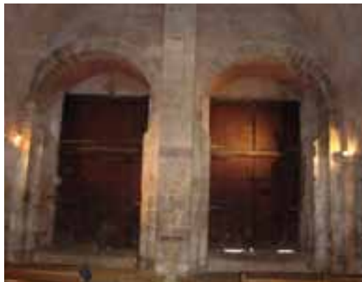
Fig. 36. Conques (Aveyron), Santa Fe, contrafachada con la bífora.
