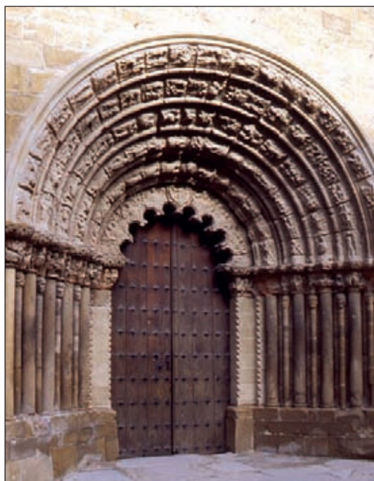
Iglesia de Santiago de Puente la Reina
