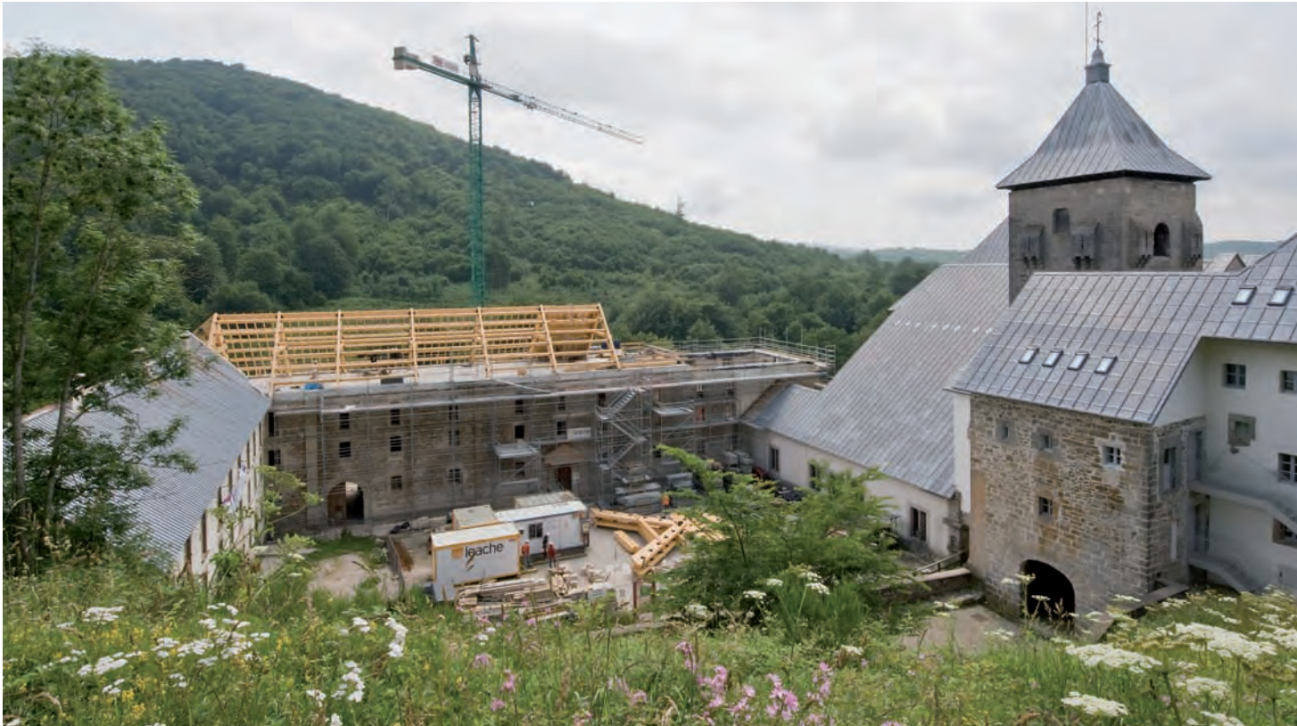
Fase del acondicionamiento de los tejados en el año 2009
