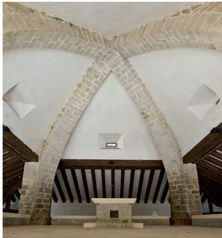
Vistas interiores y sección de la capilla del Espíritu Santo y su carnario
