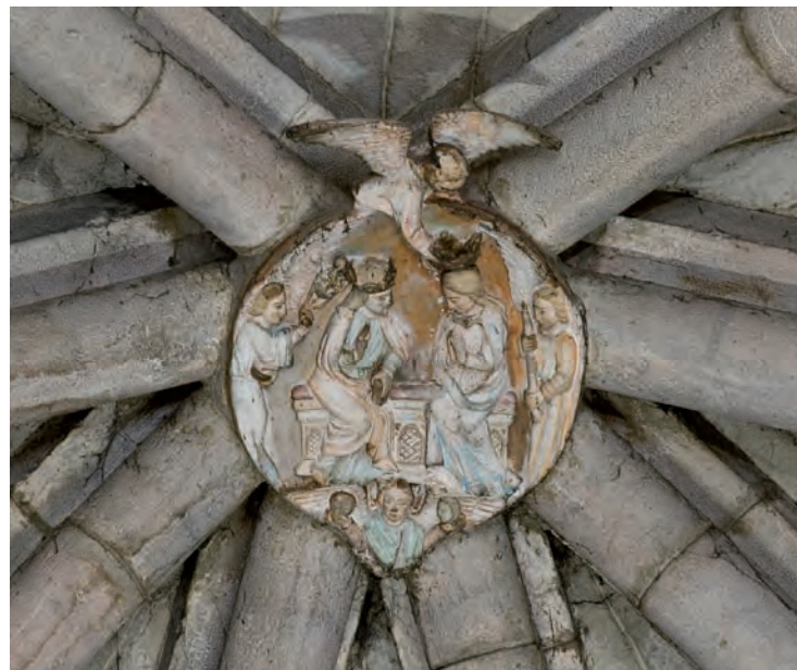
Clave de bóveda de la capilla mayor
