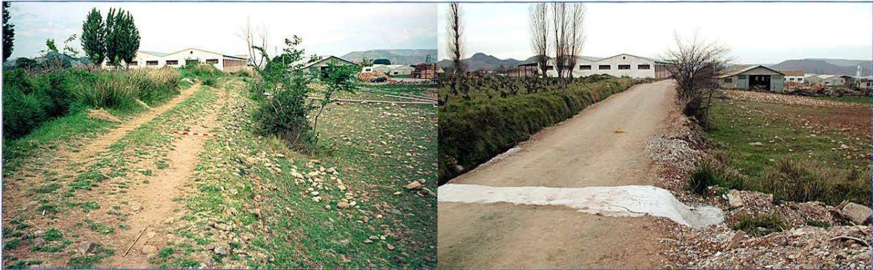
A la izquierda, el terraplén de la vía romana en Tricio (La Rioja) antes de su destrucción. A la derecha, la infraestructura de la vía romana destruida por el repavimentado con máquinas motoniveladoras y el extendido de pavimento moderno, en enero de 2003, en el mismo punto que a la izquierda.
