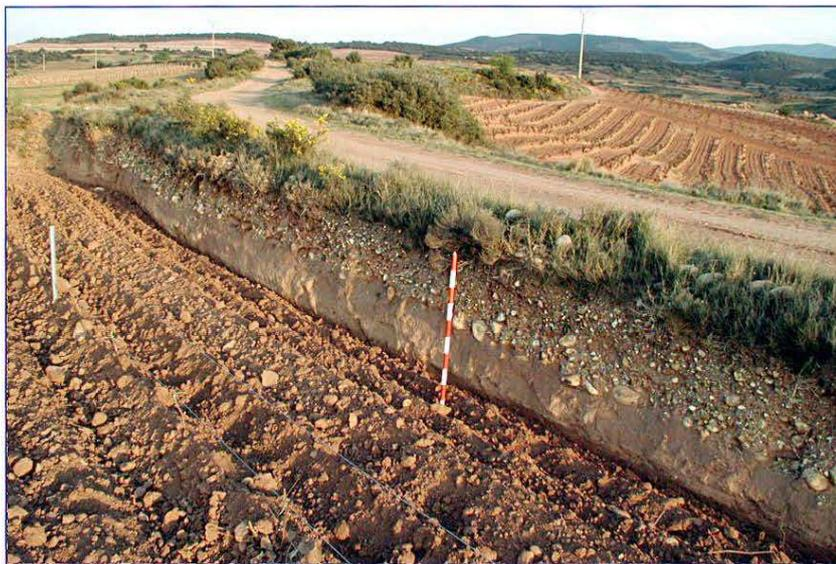
Detalle del espesor del afirmado en una sección lateral provocada por el abancalamiento de la finca colindante. Vía de Italia a Hispania entre el alto de San Antón y Alesón.
