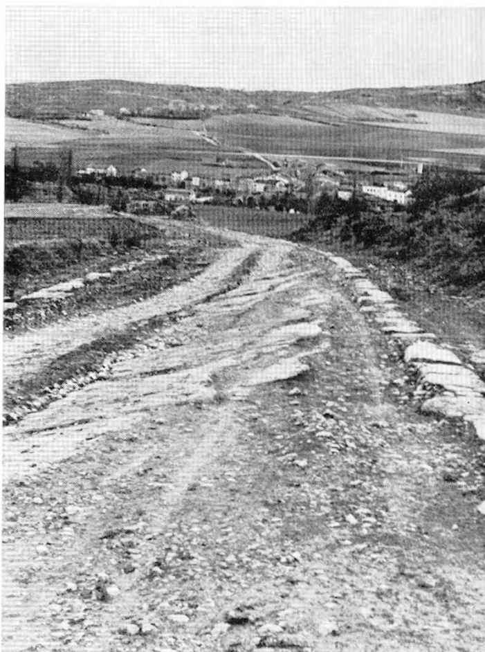
Photo 4. — La carretera antigua entre Miranda de Ebro et Armiñón. Au fond, le pont et le village d'Armiñón. (Photo J. P. Molénat.)
