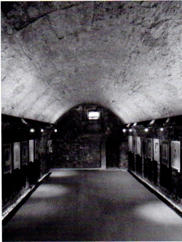
FIGURA 2. Nave de la alberguería capitular de Vic.
