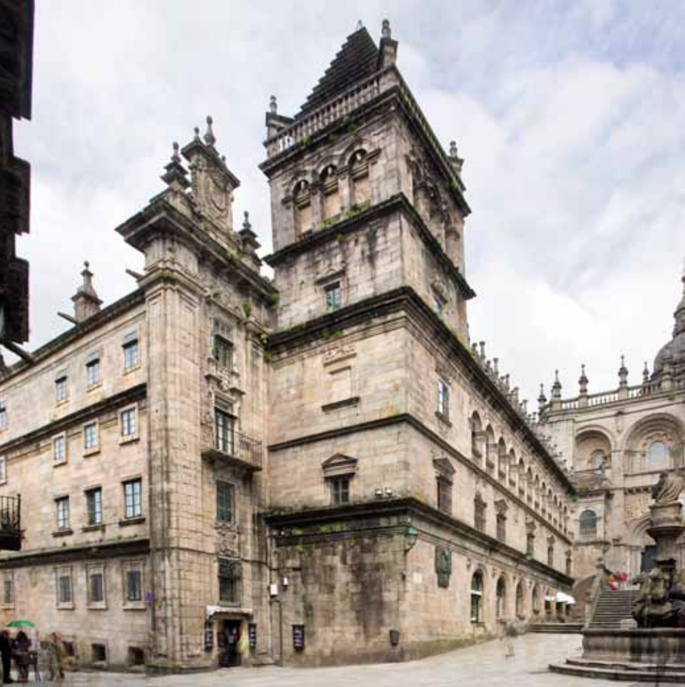
Fachadas do esconce e do chamado cuarto do Tesouro.
