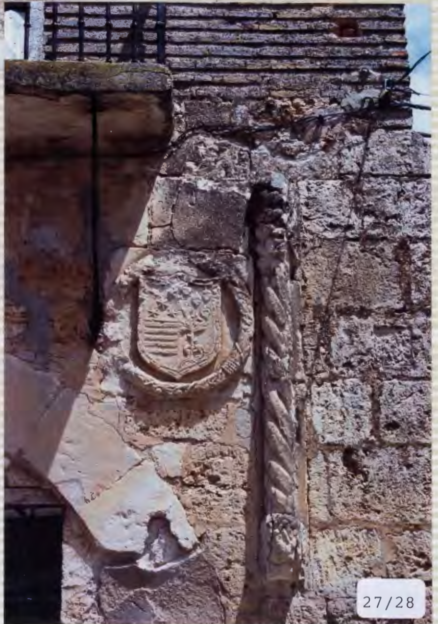
14.-CASA DEL CORDON.
