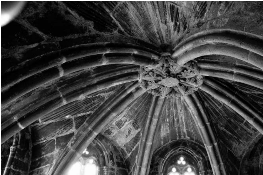
Fig. 7. Bóveda gótica del cimborrio catedralicio con su clave, recuperada durante la restauración de 2016-2018. (Archivo R. Yzquierdo).
