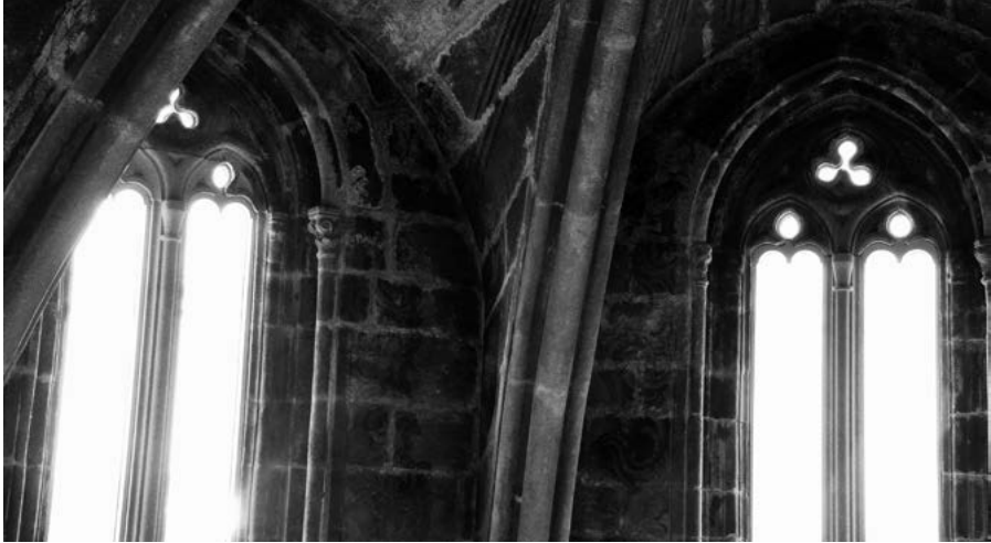
Fig. 21. Detalle del interior del cimborrio gótico con dos de sus ventanales restaurados en 2018. (Archivo R. Yzquierdo).
