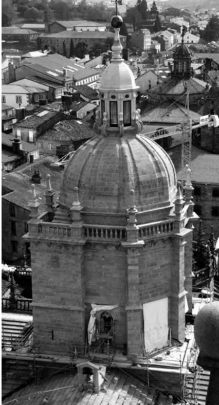
Fig. 24. Conjunto de la cúpula y cimborrio de la catedral después de la restauración de 2018. (Archivo R. Yzquierdo).
