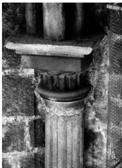
Fig. 14. Detalle de una de las columnas del interior del cimborrio y de su capitel. (Archivo R. Yzquierdo).
