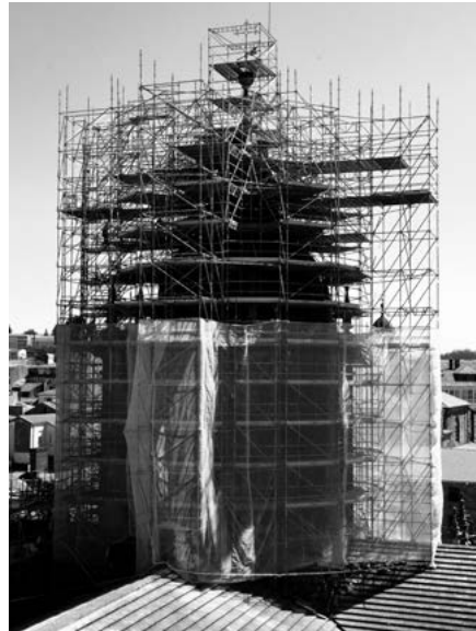
Fig. 19. Espectacular andamio para la restauración exterior del cimborrio entre 2016-2018. (Archivo R. Yzquierdo).
