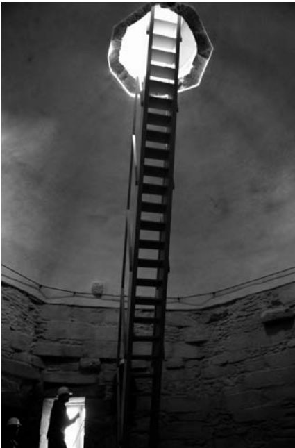
Fig. 22. Interior de la cúpula del cimborrio y escalera de acceso a su linterna tras la restauración de 2018. (Archivo R. Yzquierdo).
