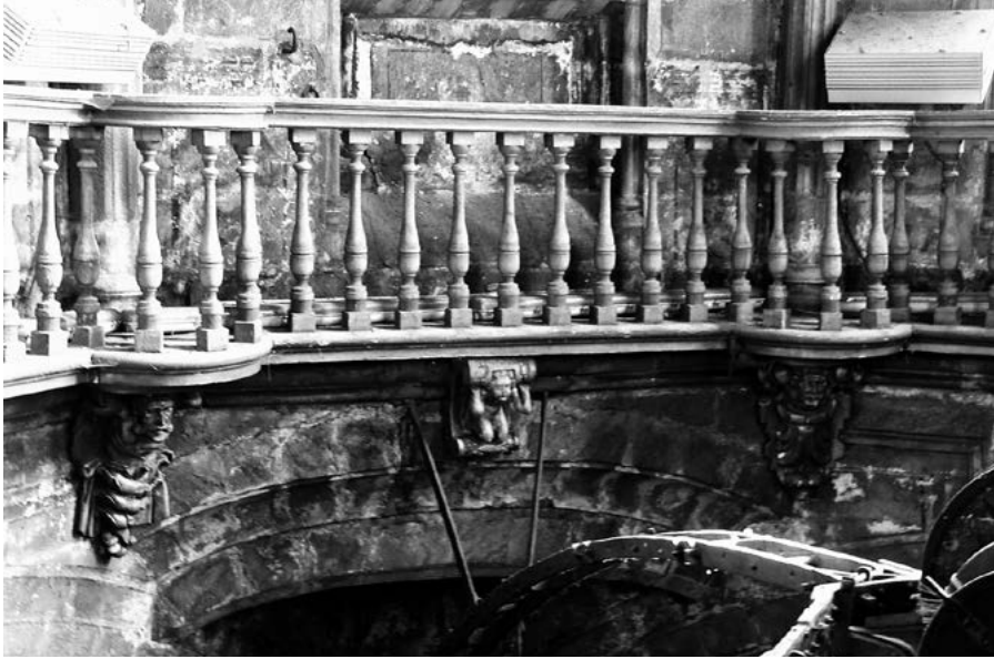
Fig. 13. Balconcillo barroco en el arranque del cimborrio. Tras sus balaustres se ven las basas de las columnas del interior del cimborrio y parte baja cegada de una de sus ventanas. (Foto gentileza de Javier Alonso de la Peña).
