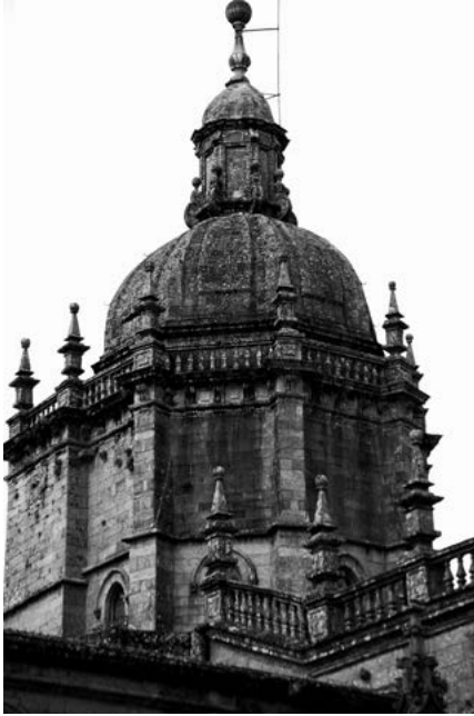
Fig. 15. Conjunto exterior del cimborrio y de su cúpula antes de la restauración de 2016-2018. (Archivo R. Yzquierdo).
