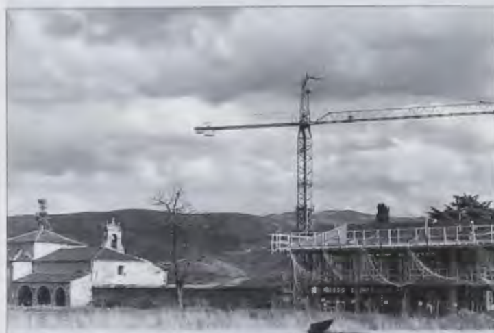
Planchada de la 2ª Planta.
