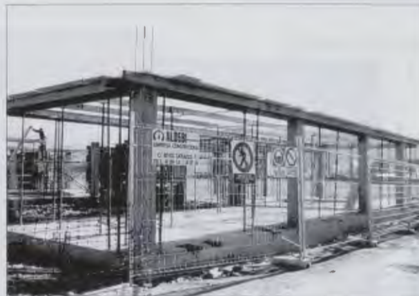
Las columnas de la planta primera listas para recibir la planchada del primer piso.
