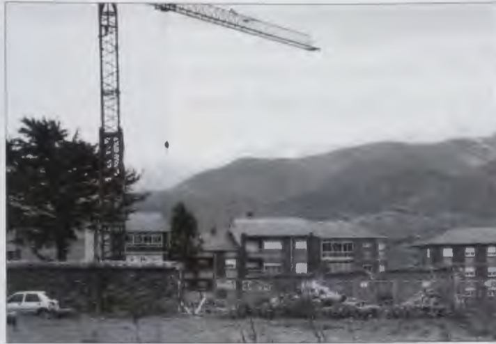
Comienzo de las excavaciones.
