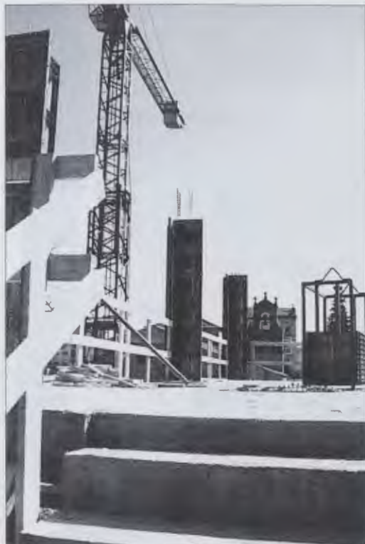
Acceso a la 2ª Planta.
