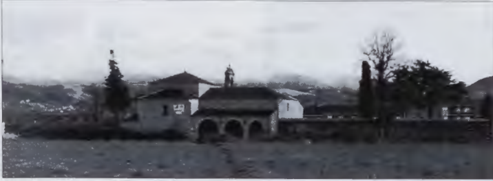
Aspecto que presentaba El Carmen antes de las obras
