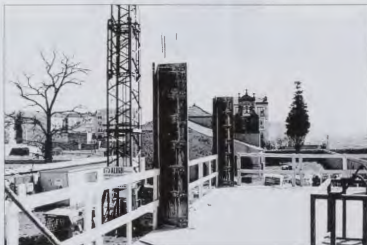
Cimentación de la 2ª Planta.
