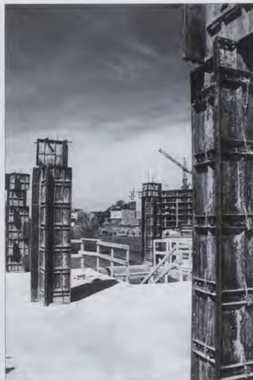
Cimientos en la 2ª Planta.
