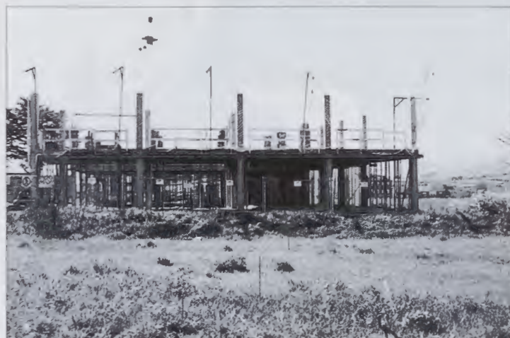
Vista de la Cimentación.
