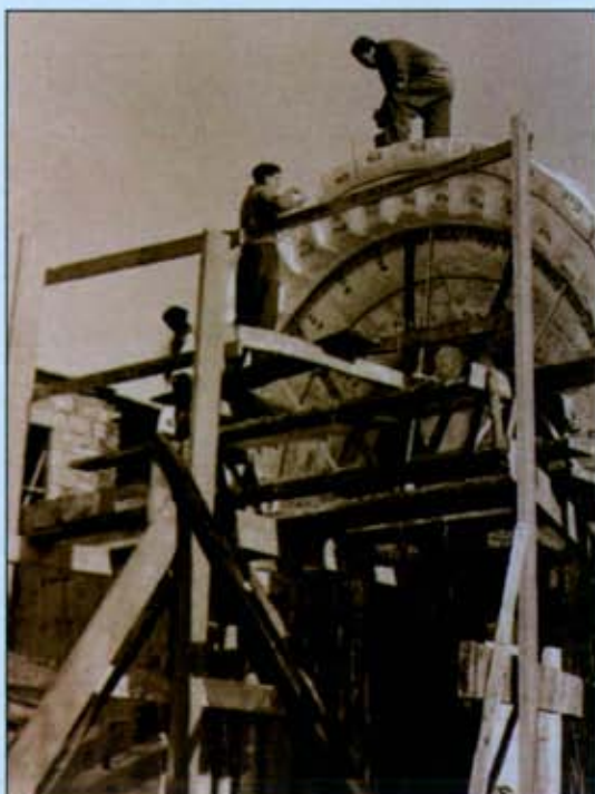
Desmontaje de la portada de San Juan y San Nicolás. Archivo Villarabid
