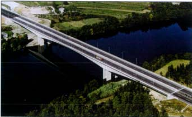
(Izda.) Puente Internacional de Tui. Revista del Ministerio de Fomento (Dcha.) José Antonio Torroja. Revista del Ministerio de Fomento (Abajo) El puente de Torroja junto al puente de 1933 en Portomarín (Jaob)
