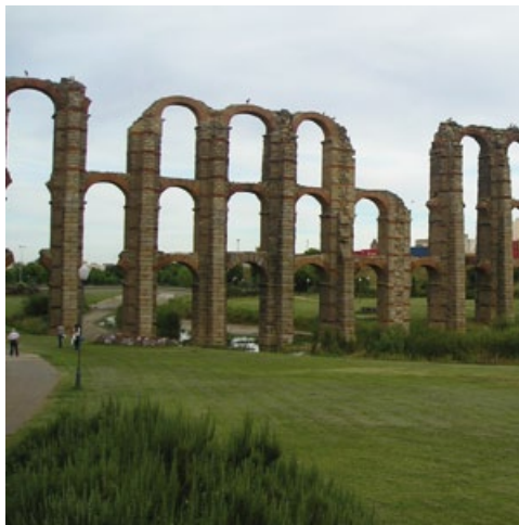
MÉRIDA. Acueducto de Los Milagros.
