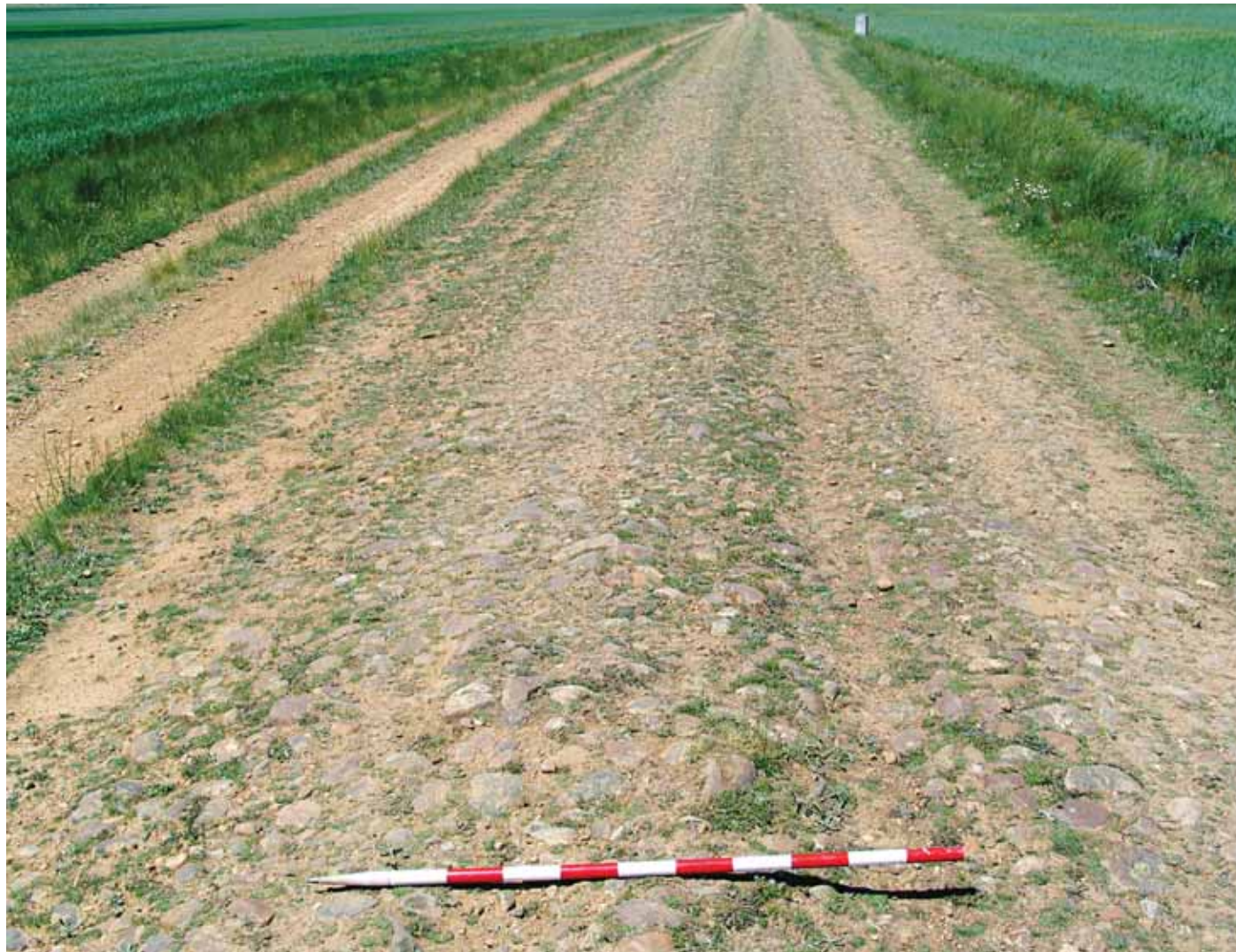
Fig. 8. Santas Martas (León). Detalle del nivel de rodadura con gravas.
