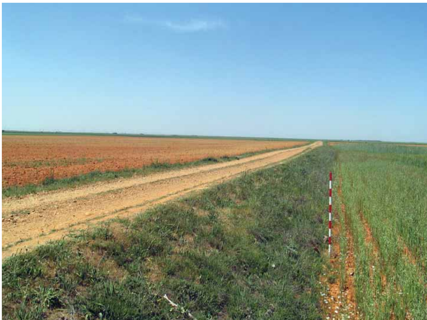
Fig. 7. El Burgo Ranero (León). Detalle de un alineamiento de la vía con los terraplenes bien conservados.
