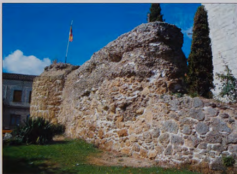
Restos de las murallas de Carrión.
