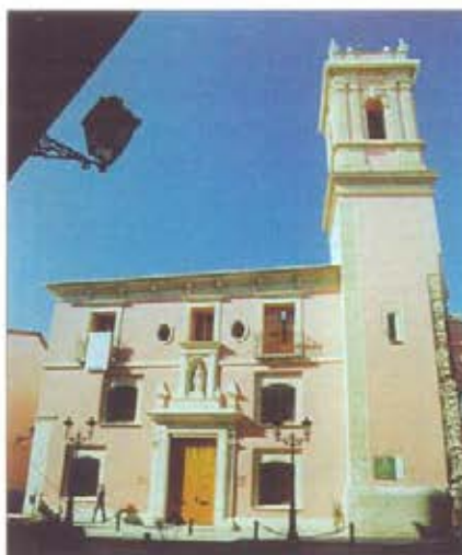
Façana del convent de Sant Vicent Ferrer
