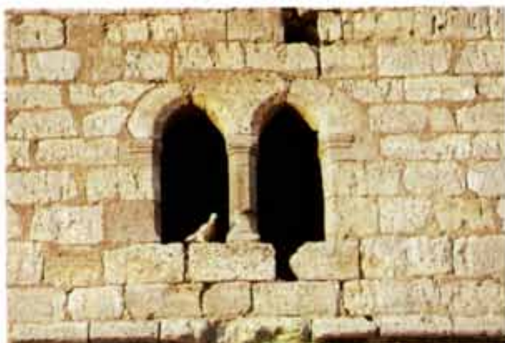
Torre de la Iglesia de San Pedro. Detalle de ventana medieval.
