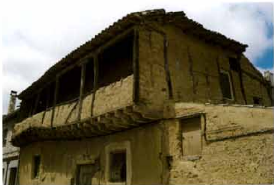
Casa con su construcción tradicional de Frómista a base de barro y madera.
