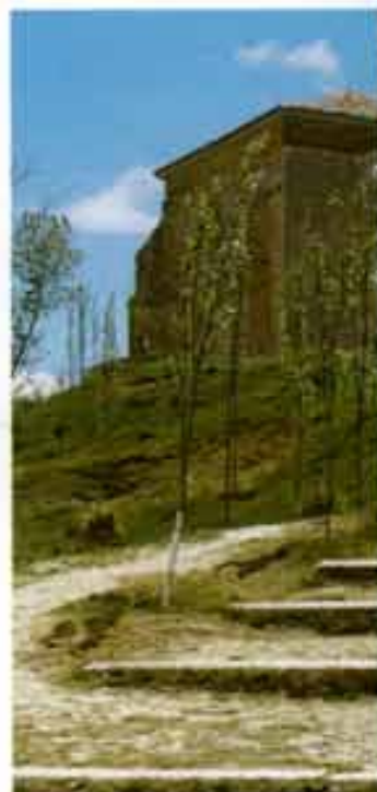
Vista general de la ermita.
