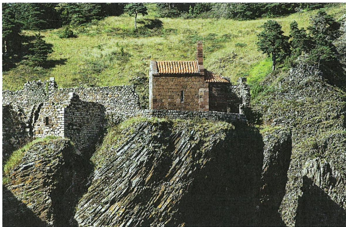
Ill. 25 - Château d'Arlempdes, chapelle castrale Saint-Jacques, état actuel après restauration (cliché Bernard Galland)
