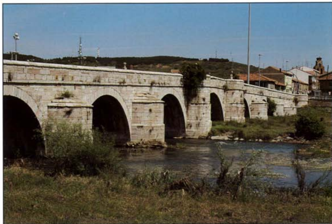
Puente sobre el río Torio en Puente Castro.
