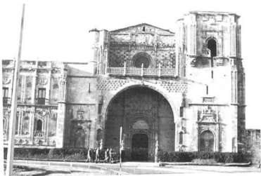
Fig. 1.- Convento de San Marcos de León. Fachada.
