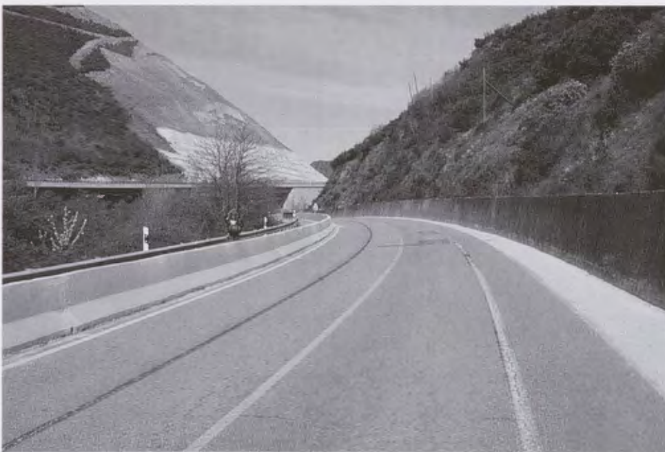
Los peregrinos en bicicleta van enjaulados entre taludes y pretiles, sin arcén para esquivar los coches en un tramo tan sinuoso
