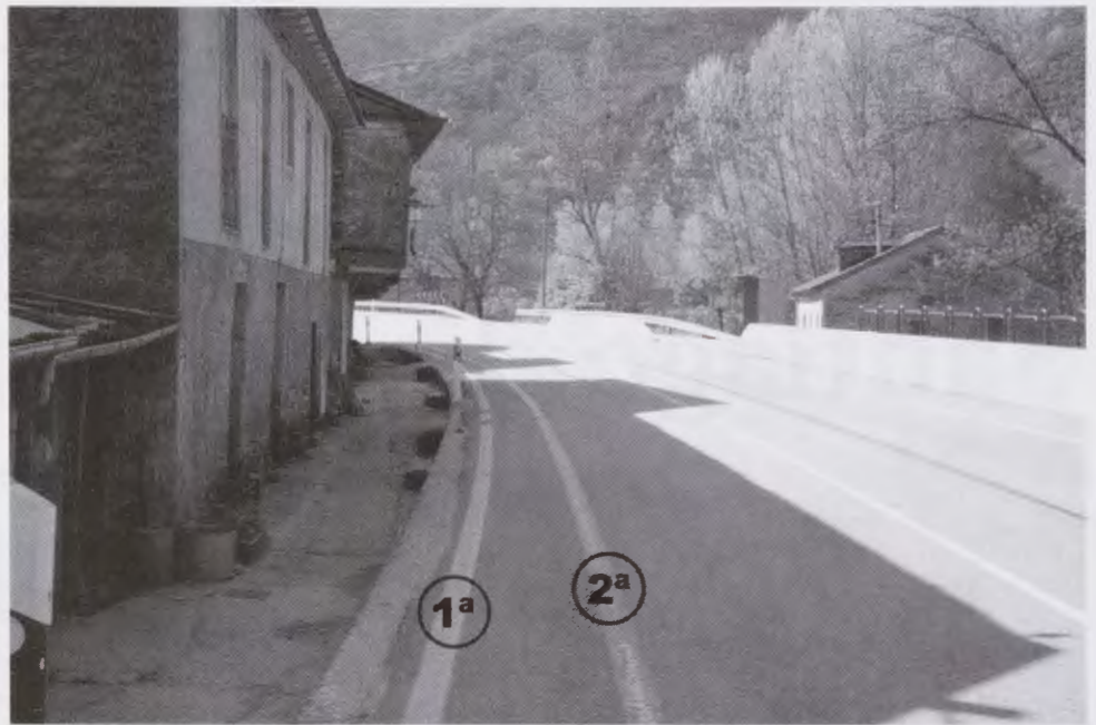
La primera línea indica por donde pasa ahora la carretera. La segunda nos señala el viejo arcén.
