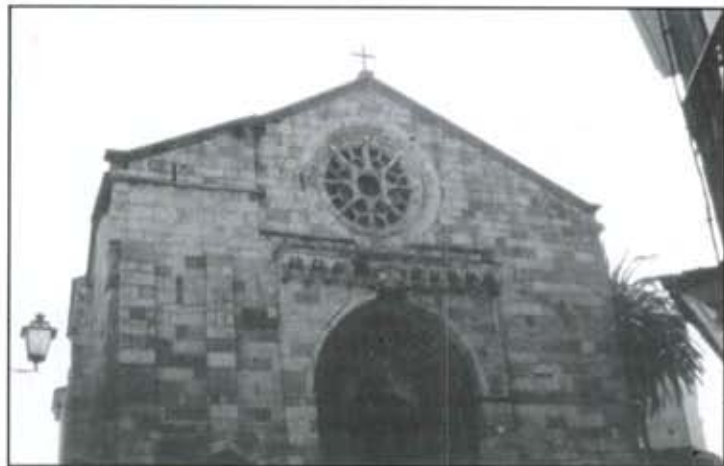
Iglesia de Santiago. Vista general de la fachada oeste.
