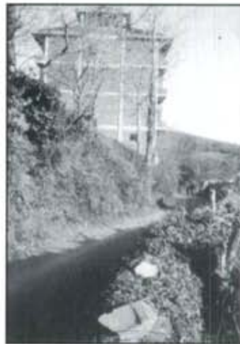
Horrible edificio nuevo en el hermoso pueblo de Ramil
