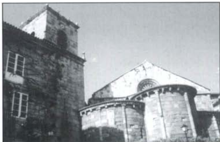
Iglesia de Santiago. Vista general del ábside.
