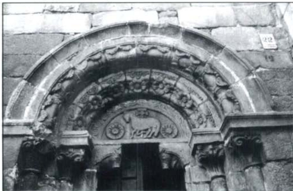
Iglesia de Santiago. Timpano de la fachada norte.
