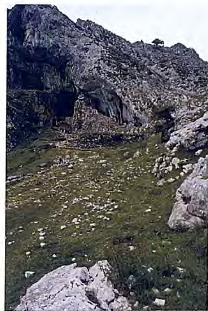
Túnel de San Adrián. Álava
