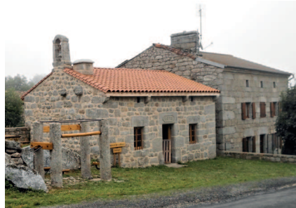
Das restaurierte Versammlungshaus von La Clauze dient heute Pilgern als Schutzhaus
