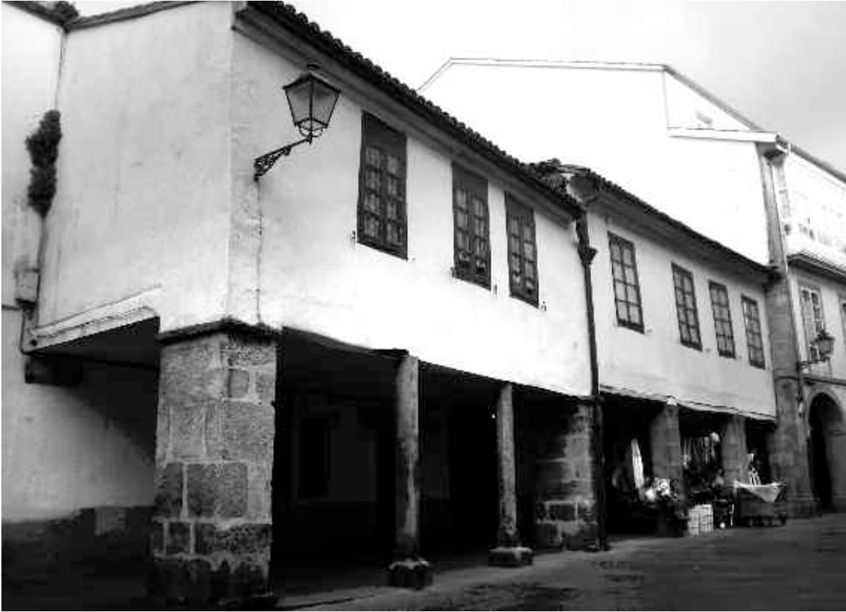
Casas de la Rúa Nova cuya estructura recuerda a los inmuebles típicamente medievales (figura 14)
