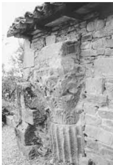
Fig. 5. Ermita de San Pedro de Artieda (Zaragoza), para cuya construcción se reutilizaron restos de una columna romana de época imperial, procedentes de algún yacimiento próximo, de los diversos que se encuentran todavía sin excavar, como lo confirma la presencia en su fachada norte de un capitel corintio sobre un tambor estriado. En peligro al encontrarse directamente afectada, como sucede con otros yacimientos y ermitas, por el recrecimiento de Yesa y la nueva cota prevista para el embalse.
