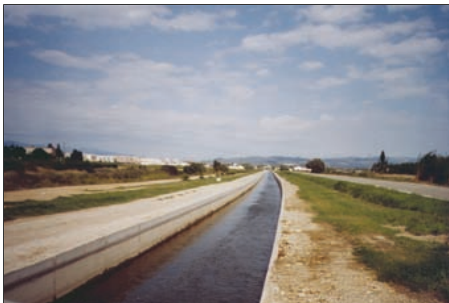
El Camino (a la izquierda de la imagen) entre San Carlos y Amposta, discurre junto al antiguo canal de navegación. (Foto del Autor)
