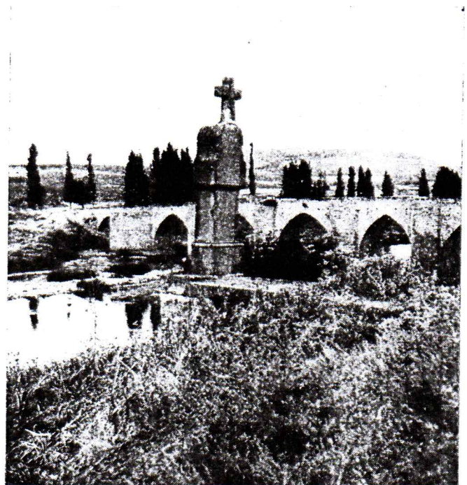
Puente de Santo Domingo de la Calzada.
