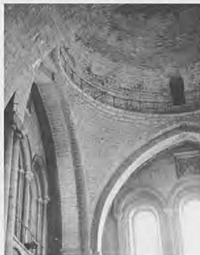
FIGURA 8. Périgueux, San Etienne, bóveda del coro (foto: autor).
