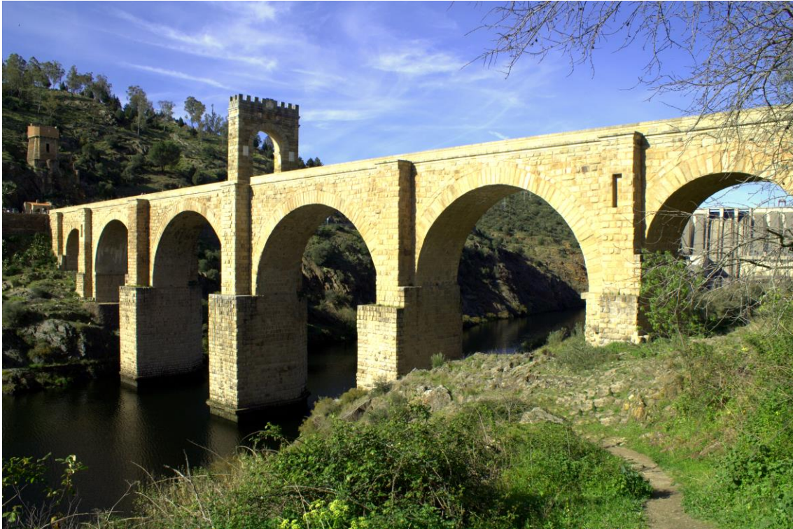
Imagen 3. Puente Romano de Alcantara. Fuente: Autores
