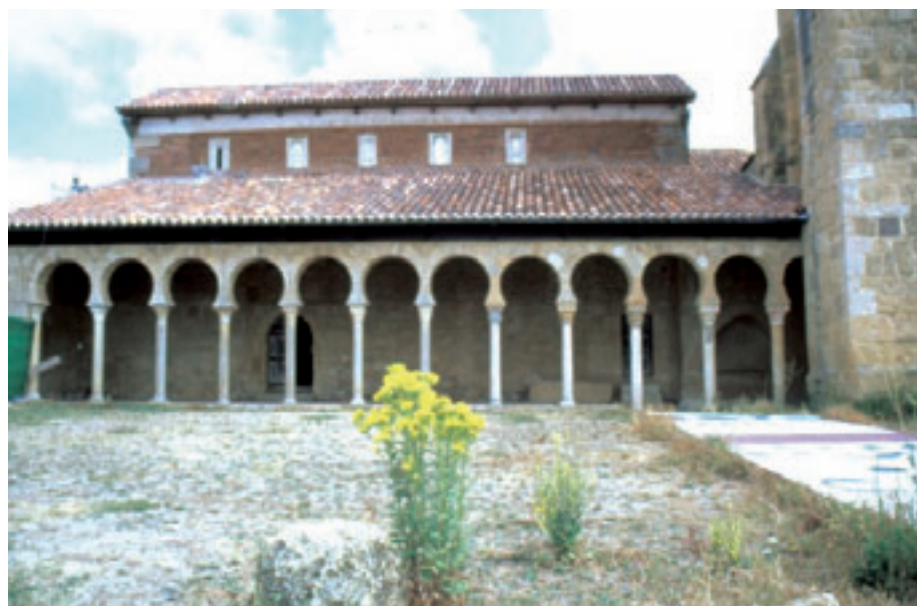
Fig. 16. RUTA VADINIENSE. SAN MIGUEL DE ESCALADA: vista parcial del monasterio. En primer término, la "Flor de Santiago". (Foto: A.P.)
