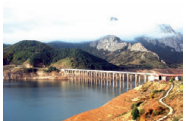
Fig. 2.-RUTA VADINIENSE. RIAÑO: Viaducto sobre el pantano. (Foto: C.P.)
