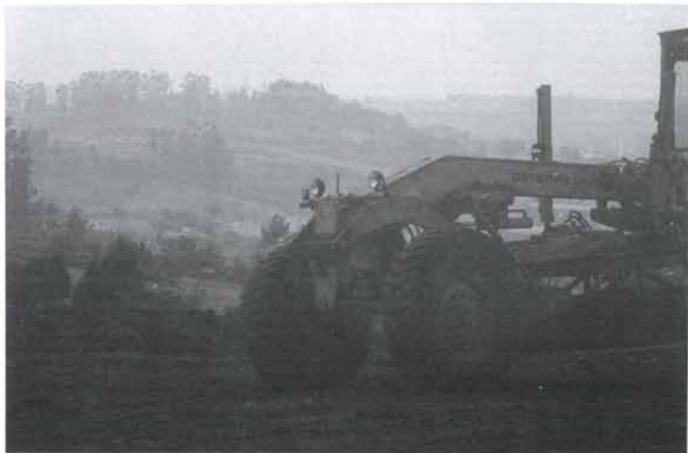
A mediados de julio se adjudicaron las obras a la empresa Dragados y Construcciones e inmediatamente han entrado las grandes máquinas en el "Monte del Gozo".
